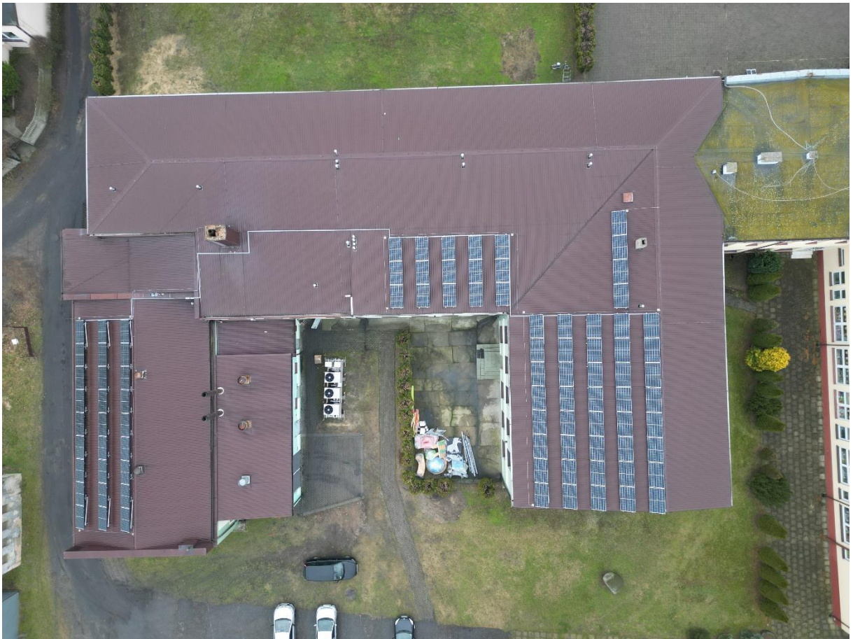
Zdjęcie 2 Widok dachu obiektu
