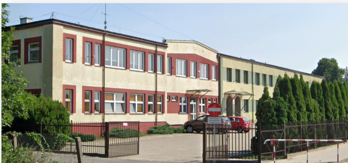
Zdjęcie 1 Elewacja frontowa.
