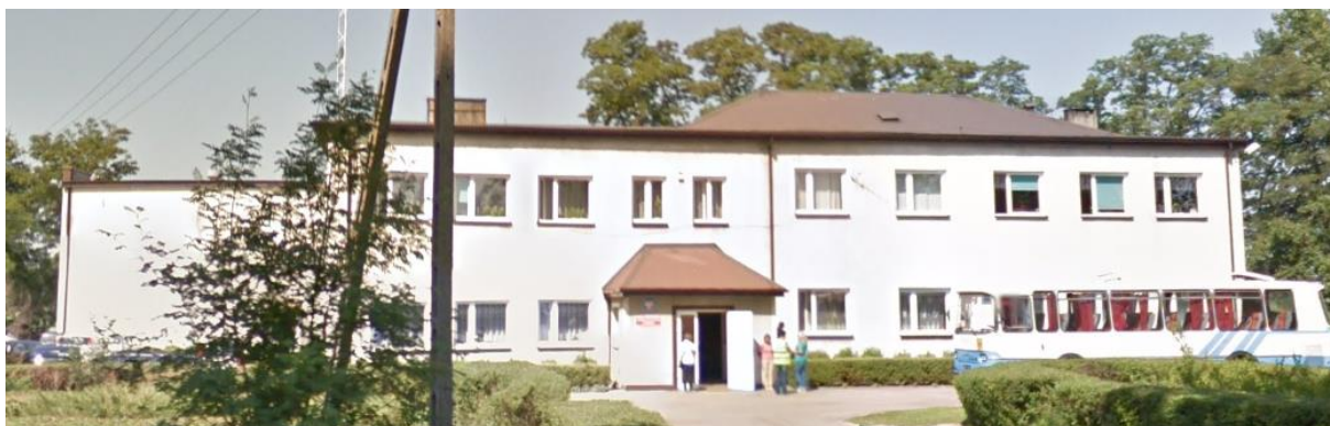
Zdjęcie 1 Elewacja frontowa.
