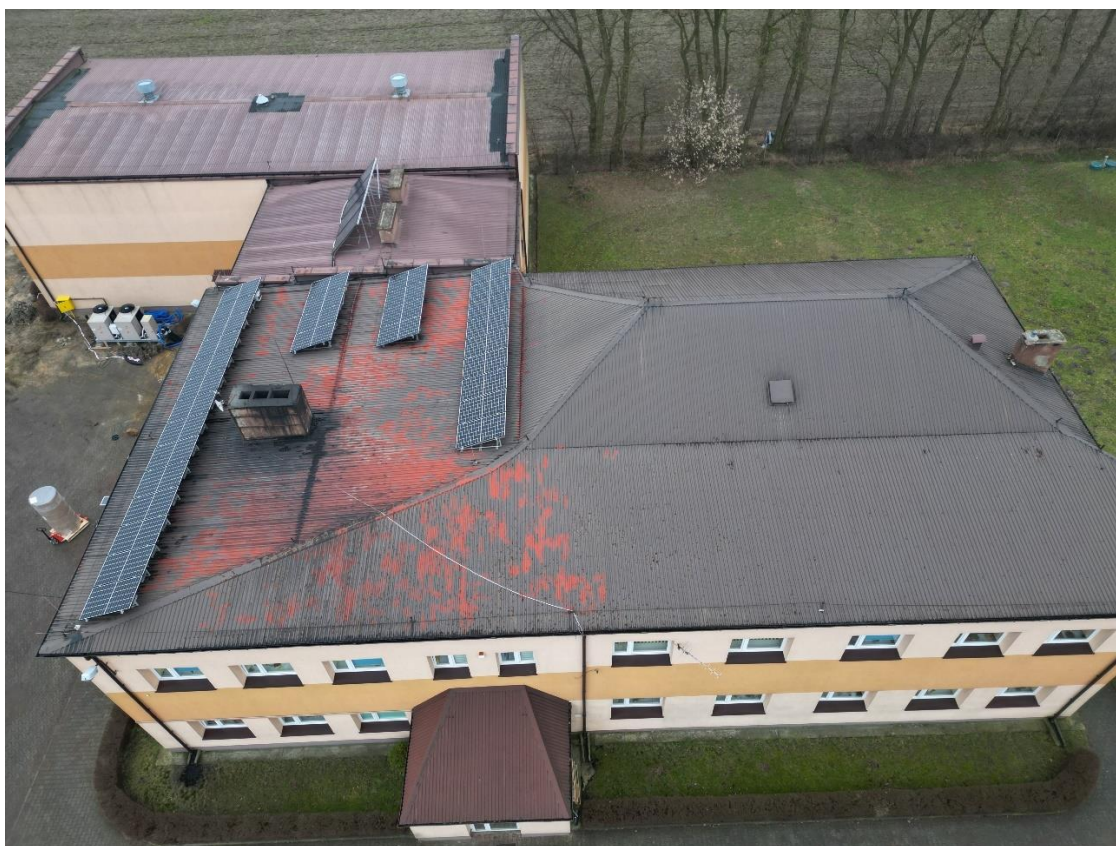
Zdjęcie 2 Widok dachu obiektu
